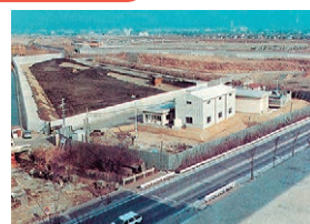
● 勝竜寺埋立処分地(第1期) 竣工 (S55.12)
