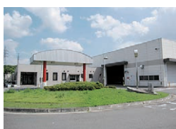
● スtockヤード 竣工 (H13.3)
